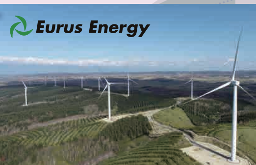
北海道道北地域にて、国内最大規模の風力発電・送変電・蓄電事業の運転を開始
