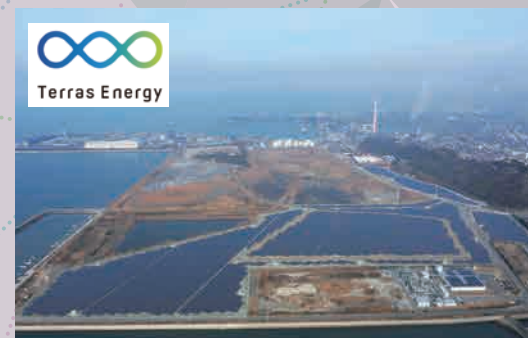
国内最大規模の太陽光発電事業者、テラスエナジー(株)を完全子会社化(写真はテラスエナジー熊本荒尾ソーラーパーク)
