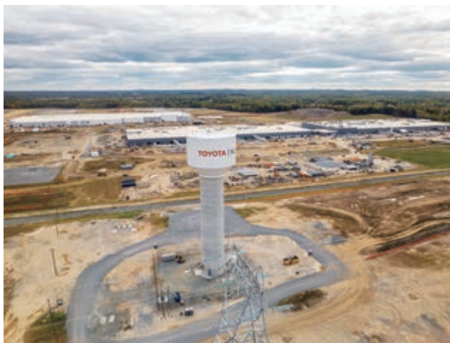
建設中の電池工場
