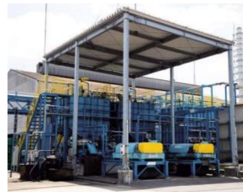
油水分離装置
