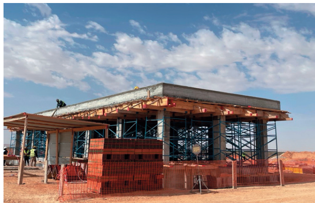
チュニジアで建設中の太陽光発電所
