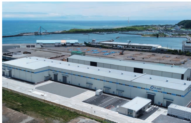
(株) プラニック 工場 外観の様子
