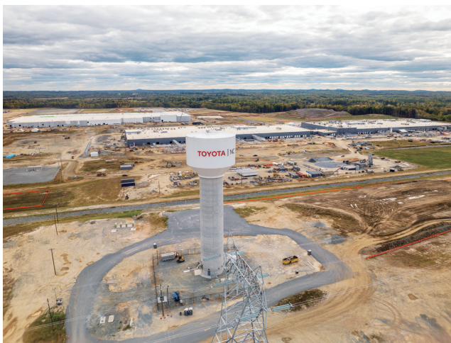
建設中の電池工場
