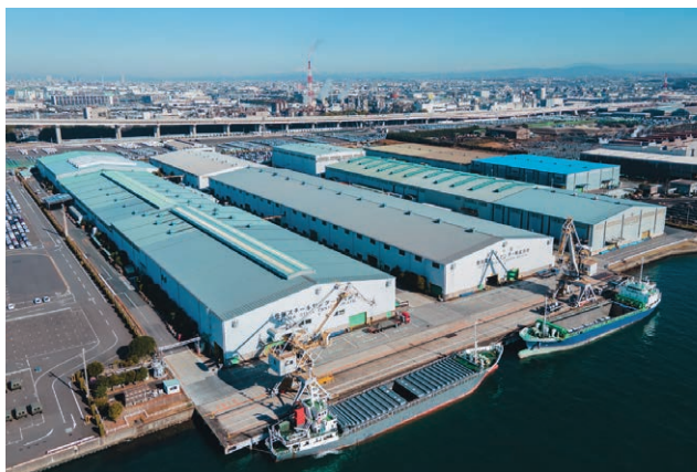
豊田スチールセンター（株）の外観の様子
