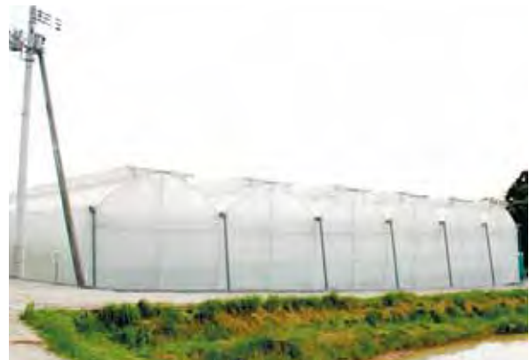
大型鉄骨ハウス施設(通称:エアハウス)
