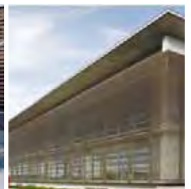
ルーバーの設置
