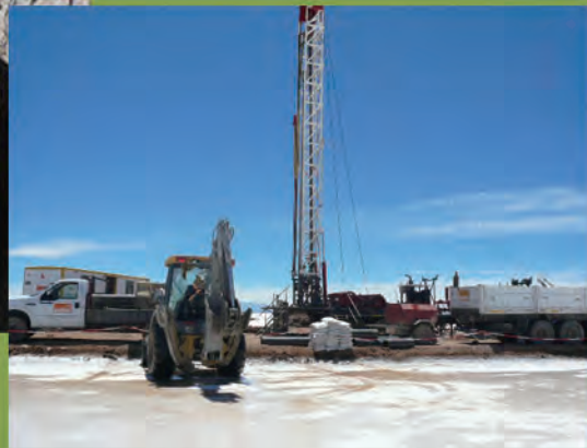
かん水生産井戸の掘削工事 ▶
