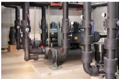
天津豊田鋼材加工有限公司(中国)で導入した 地中熱ヒートポンプ
