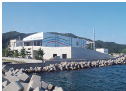
2013年4月から本格操業を開始した(株)ウェストバイオマスの下水汚泥炭化工場
