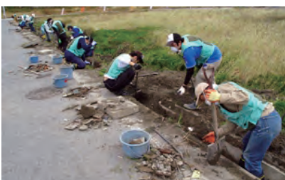
陸前高市内住宅地の側溝の土出し作業
