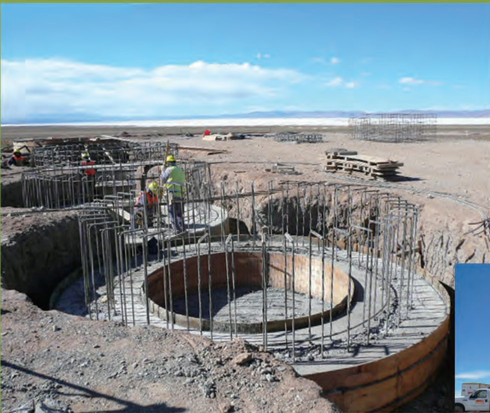
▲ 建設中の石灰工場のタンク
