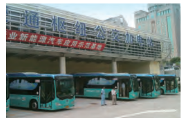
中国パートナー・普天新能源のEVバス充電ステーション
