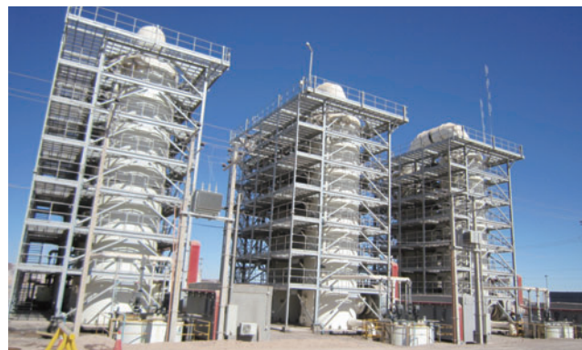
砂漠の真ん中にそびえるブローアウトタワーで、ヨードを抽出・濃縮する
