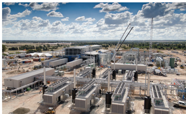
環境への負荷を最小限にするために、水処理プラントを建設 (写真は、近隣鉱区で建設中のプラント)
