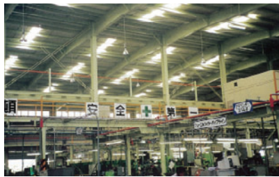
豊通ニューバックの明かり窓 (上：外側、下：内側)
