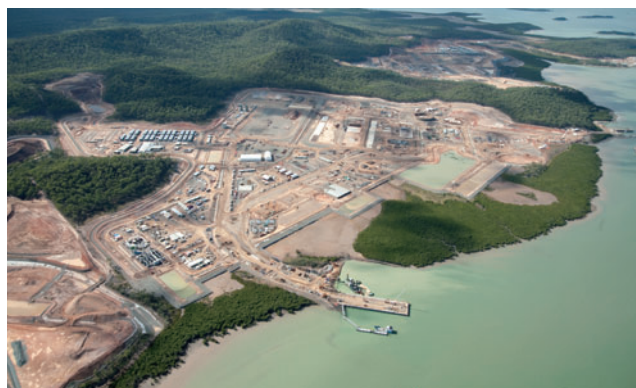
グラッドストーンの港湾地区で建設中のLNG化プラント
