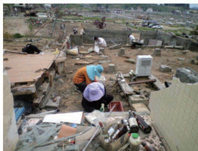
津波で流された家屋のがれき撤去
