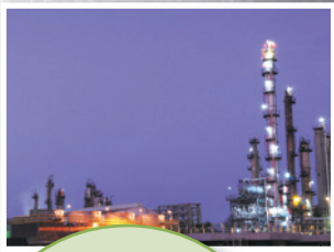
エチレングリコール製造工場
