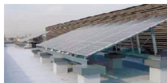
太陽光発電システムの設置(豊田支店、北海道支店)
