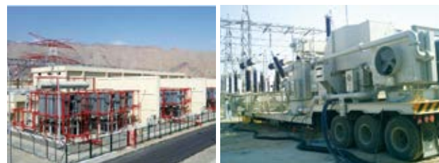
固定式変電所イメージ((株)東芝提供) 移動式変電設備イメージ((株)明電舎提供)
