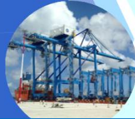
港湾荷役クレーン
