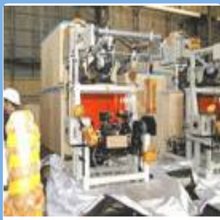
設備調達・据付
