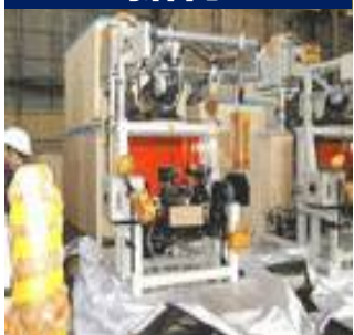
設備調達・ 据付
