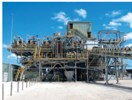
珪砂精製設備
