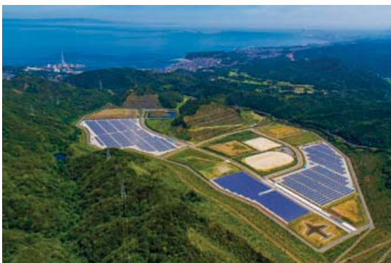
株式会社ユーラスエナジーホールディングスの岬太陽光発電所
