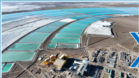
炭酸リチウム生産 第2期工場設備工事完了 生産キャパシティ42,500 t へ
