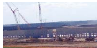
HEV4ラインの建設状況(2023年3月)
