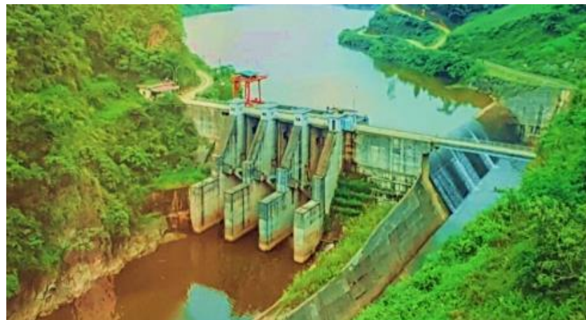
ノイファット水力発電所 (ベトナム)
