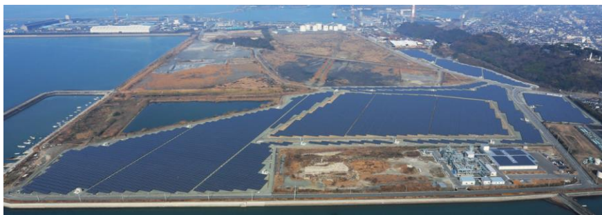
テラスエナジー熊本荒尾ソーラーパーク
