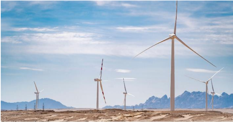
スエズ湾風力発電事業（エジプト）
